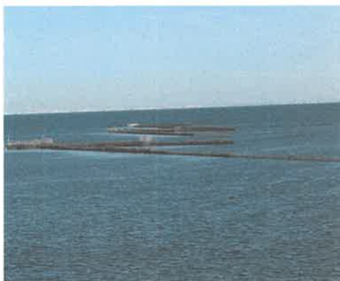
3- Vue générale de la charfiya
